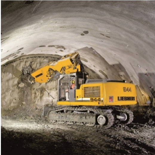
Figur 12 Tunnelgrävmaskin för tunneldrivning i jord
